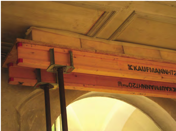
Stützbalken unterhalb der Empore von St.Lorenz.
