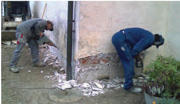
Endlich - Beginn der Außensanierung von St. Lorenz.
