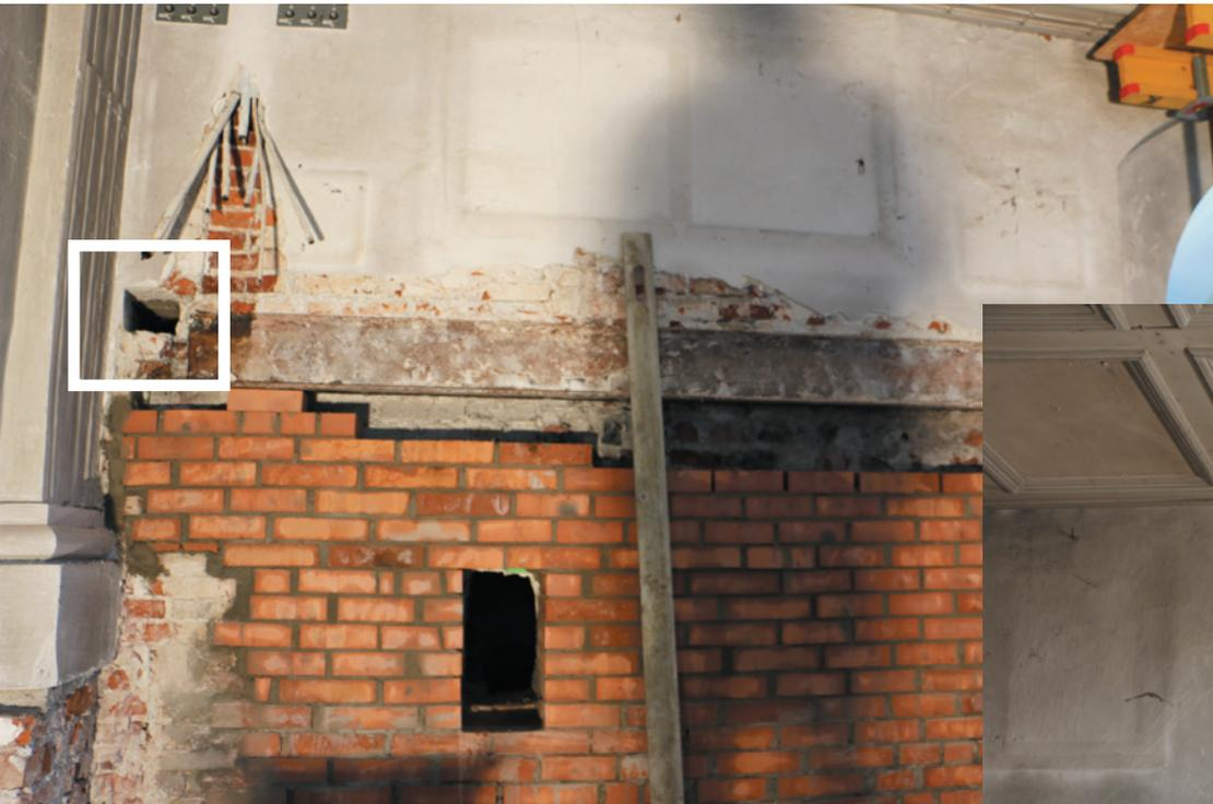
**25. September 2015:** Für die Beichtstühle wurde bei deren Einbau die Rückwand etwas verschmälert, um Platz zu gewinnen. Nach dieser Entdeckung beim Abbau der Beichtstühle wird die Kirche kurzfristig statisch als gefährdet eingestuft, bis die fehlenden Ziegel wieder ersetzt sind.
