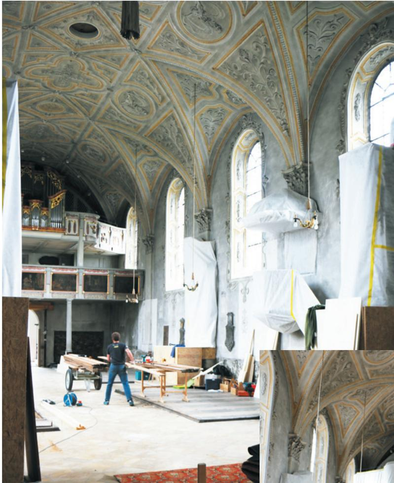
**25. August 2015:** Altäre, Kanzel, Empore und Orgel werden teilweise verschalt und in luftdurchlässige Spezialfolie verpackt.
