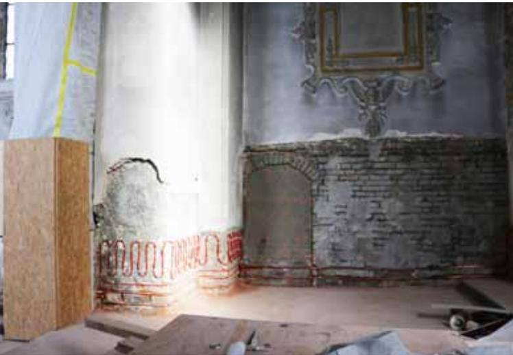
Die Heizschlangen der Wandtemperierung sind montiert.
