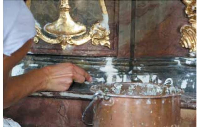
Nach dem Entfernen abgeplatzter Farbe wird die schadhafte Stelle verfüllt.
