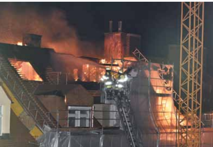
Einsatz der Feuerwehr beim Brand eines Dachstuhls.
