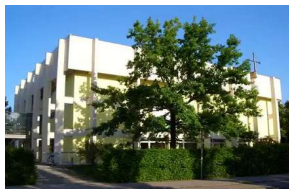
Pfarrzentrum St. Thomas Cosimastrasse 204
